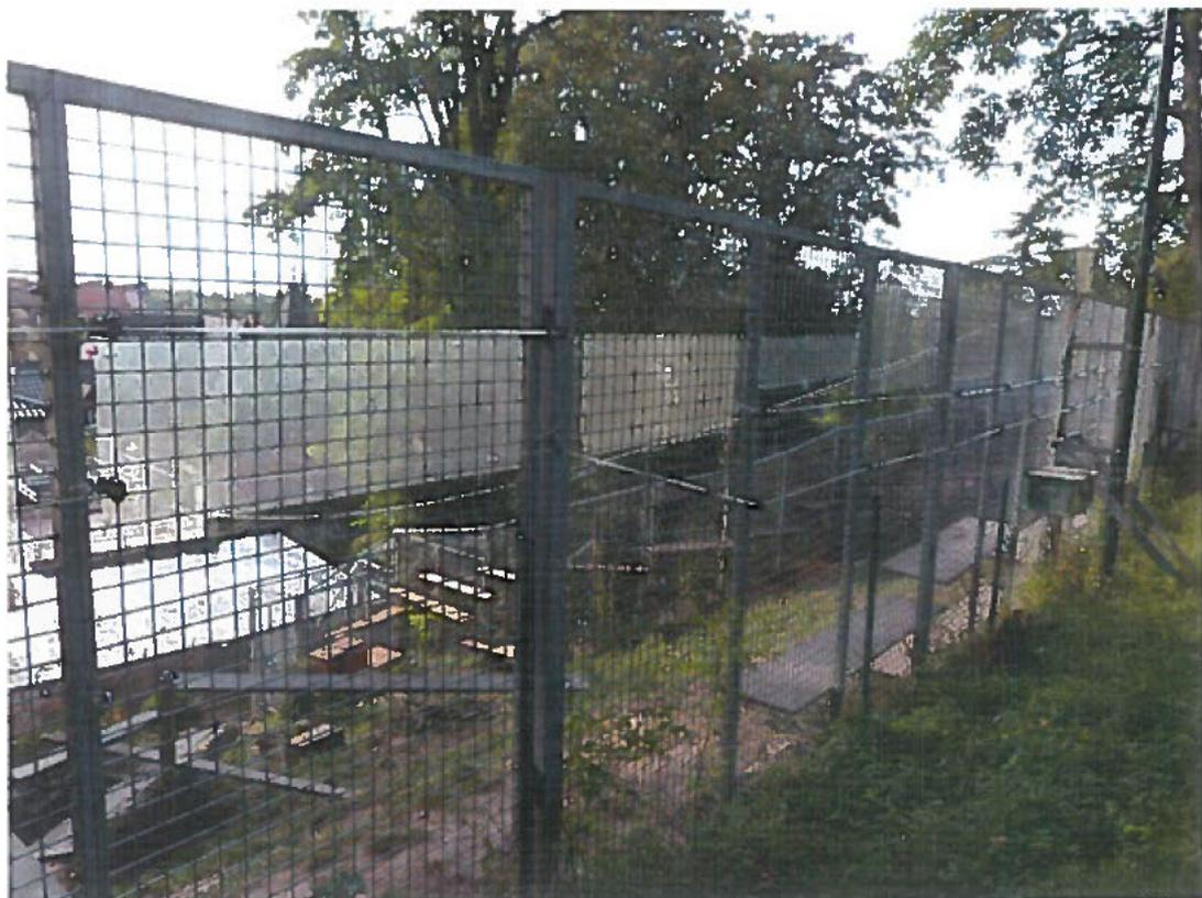
Zaunelemente mit glattem Abrutsch-Übersprungschutz aus Plexiglas
