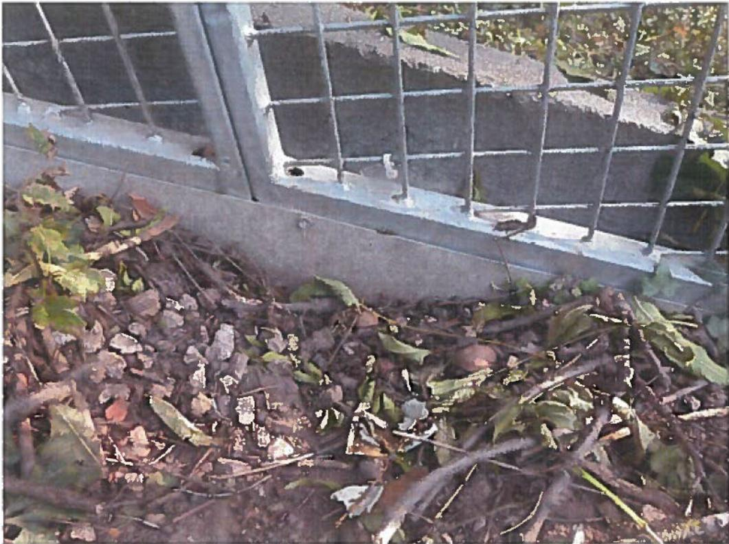
Verankerung der Zaunelemente in untergrabungssicherem Fundament
